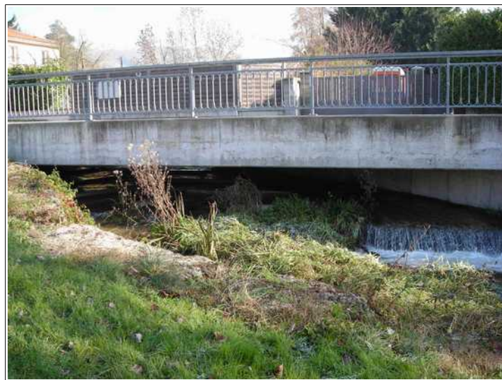
Pont de la RD143b vu depuis l'aval, on notera la faible hauteur de son tablier.
