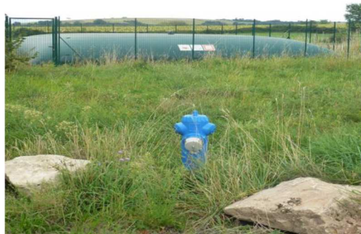
Défense incendie route de Pré Maria
